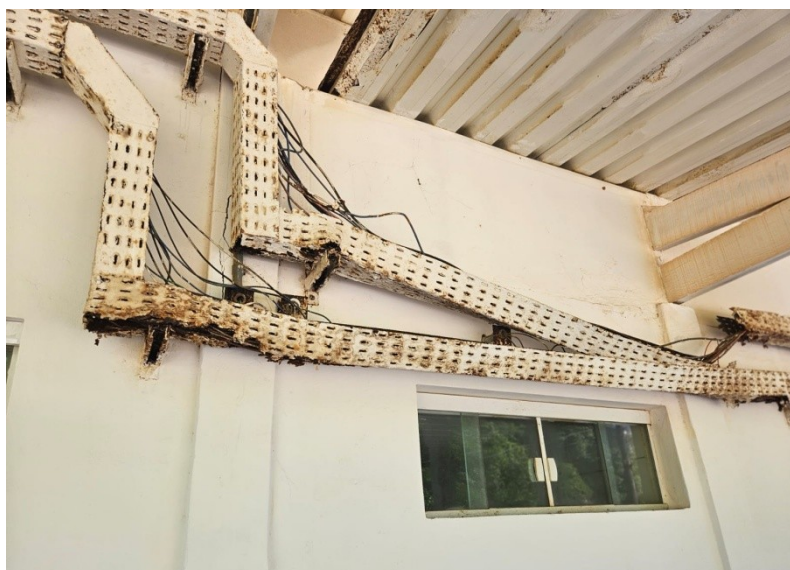
Foto 2 – infraestrutura elétrica deteriorada
