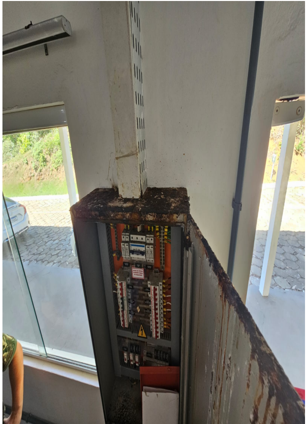
Foto 3 e 4 – quadro elétrico com adaptações em desacordo com a NR10 e deteriorado.
